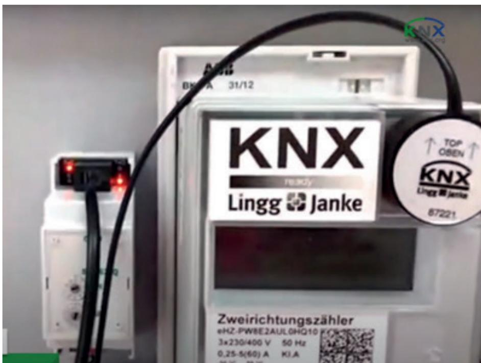
*El cabezal óptico lee los datos del contador y los transmite al bus KNX, como indica el LED rojo que está iluminado y está situado en la parte superior izquierda.*
