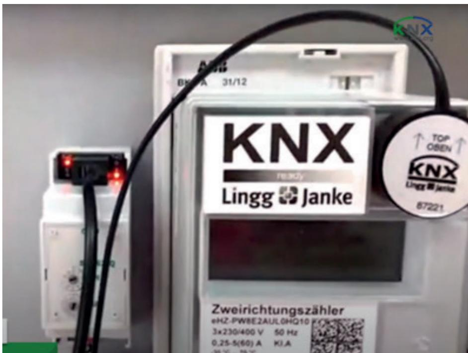
Der optische Kopf liest die Daten des Zählers aus und überträgt sie auf den KNX-Bus, wie die rot leuchtende LED links oben anzeigt.
