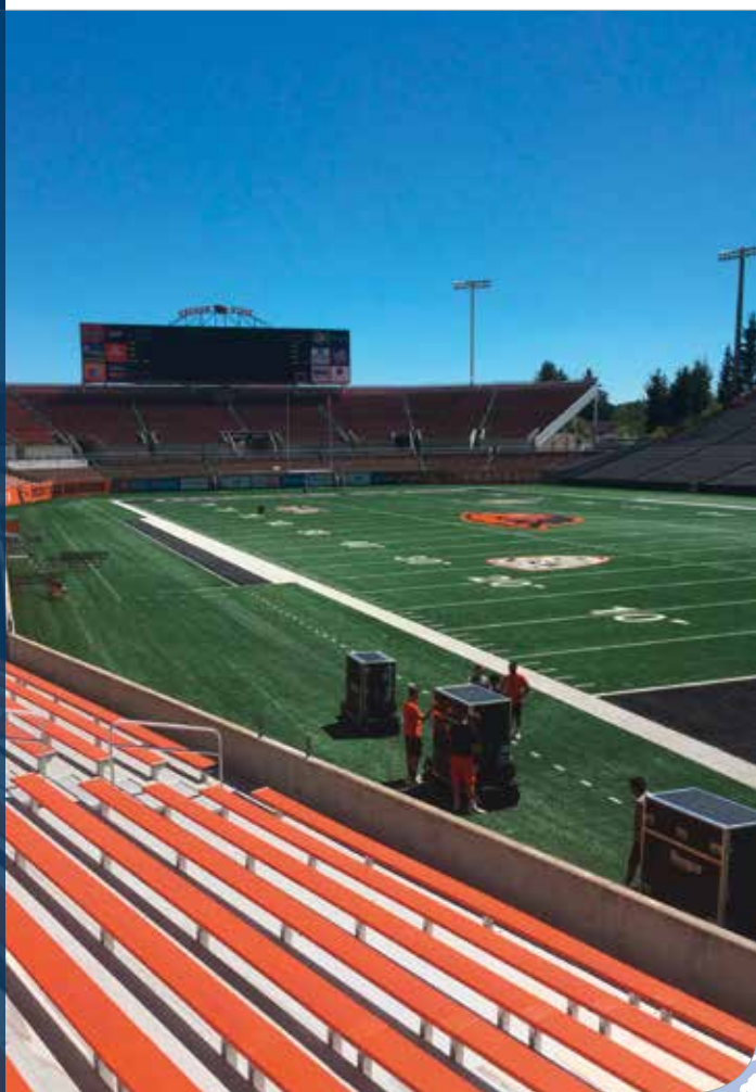
Das Reser Stadion rüstet die Beleuchtung mit der KNX Gamma Beleuchtungssteuerung nach.
