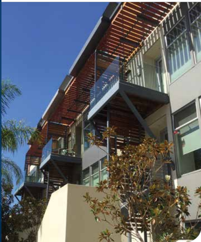
KNX Technologie in einem Wohngebäude von Los Angeles
