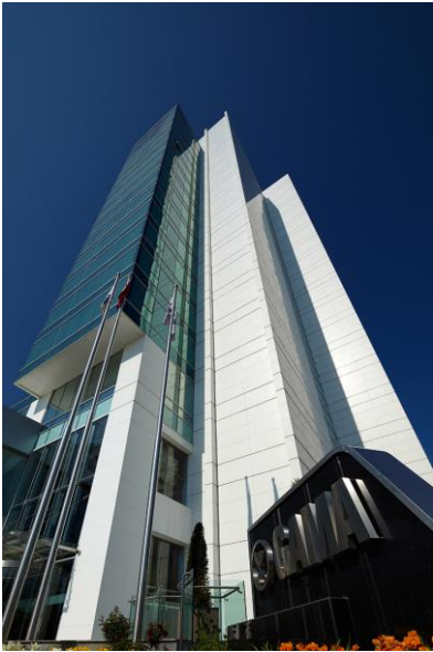
Fig. 2: Au siège GAMA à Ankara, KNX permet de s'assurer que l'électricité, le gaz et l'eau sont utilisés aussi efficacement que possible.
