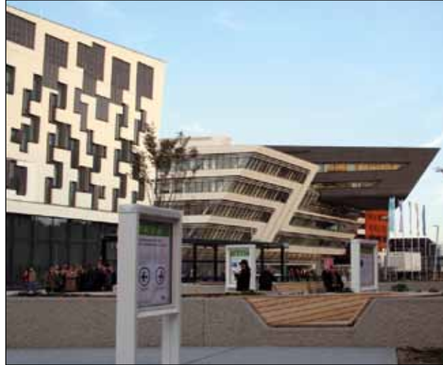
Außen unterschiedliche Architektur, innen ein gemeinsames technisches Konzept – KNX am Campus der WU Wien.
