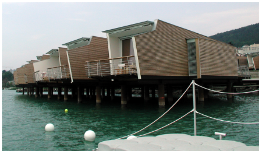
Blick auf die auf Stelzen im See stehenden Hotel-Pavillons
