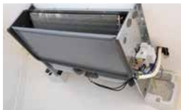
ekinex® KNX Aktor/Kontroller für Gebläsekonvektoren, montiert im Gebläsekonvektor. Ein 0–10 V Signal wird ausgesendet, um den Brushless-Motor mit der Inverterkarte zu steuern
