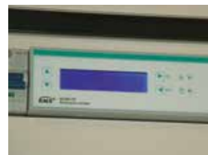
Ein ekinex® KNX Mischaktor steuert den Servomotor eines Mischventils, das für die korrekte Fluidtemperatur in den Gebläsekonvektorkreisläufen sorgt
