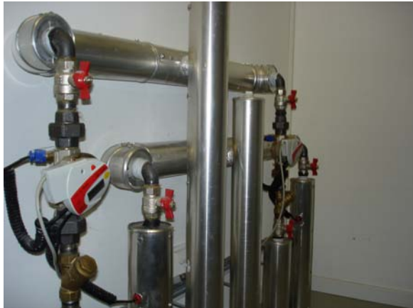
Wärmezähler mit M-Bus-Schnittstelle und M-Bus-KNX-Gateway Heat meters with M-Bus interface and M-Bus-KNX-Gateway
