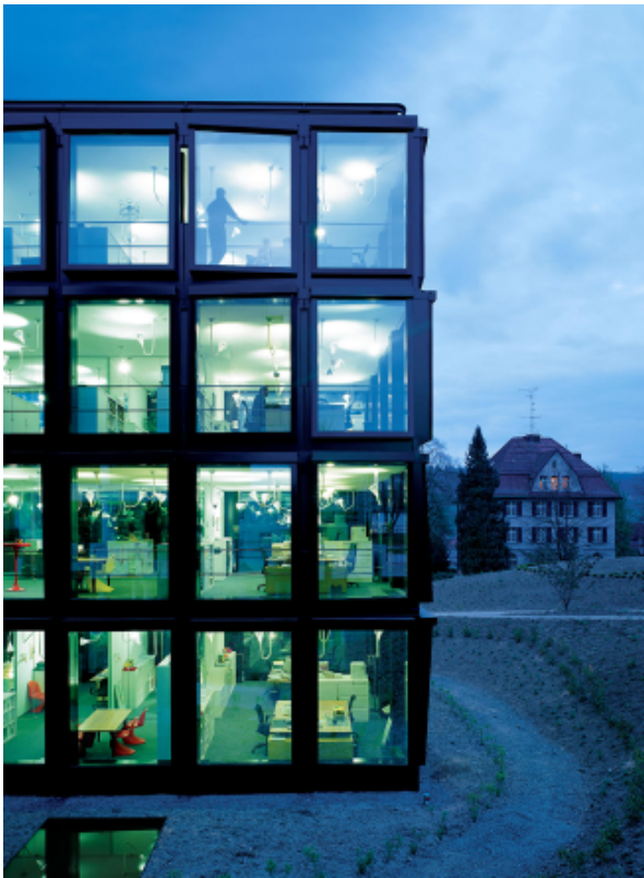
Blick auf die ungewöhnliche Fassade des Erweiterungsbau
