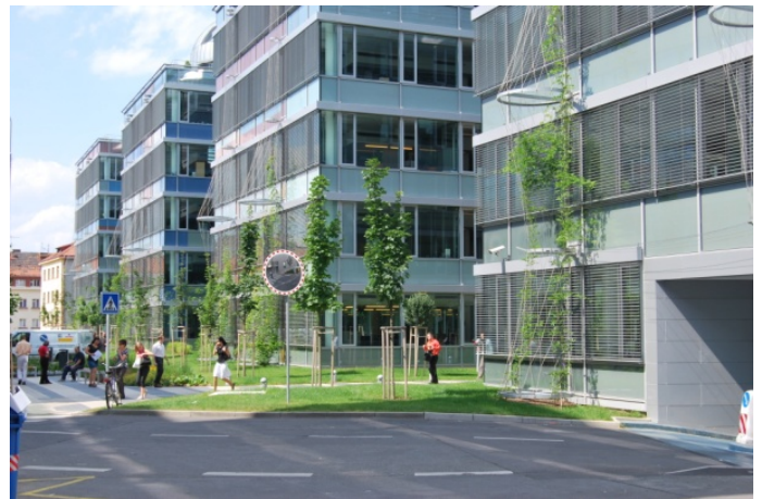
Foto 2: La sede de la empresa de la compañía de seguros más grande en la República Checa obtiene un mejor balance energético de 60% gracias a la automatización en red de todas sus funciones del edificio a través de KNX
