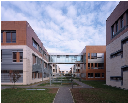
Foto 1: Convincente optimización del control de iluminación con KNX en la sede de la empresa Infineon basado en hechos concretos: ahorro de energía de más de 100.000 € al año.
