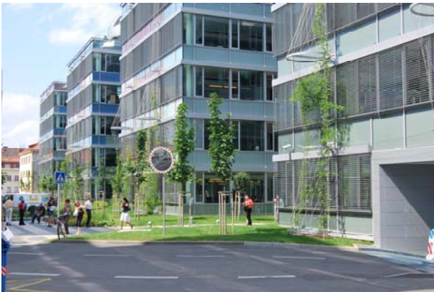
Figura 2: La sede della più grande compagnia assicurativa nella Repubblica Ceca ha potuto migliorare il bilancio energetico del 60% grazie all'automazione integrata di tutte le funzioni presenti nell'edificio tramite KNX.
