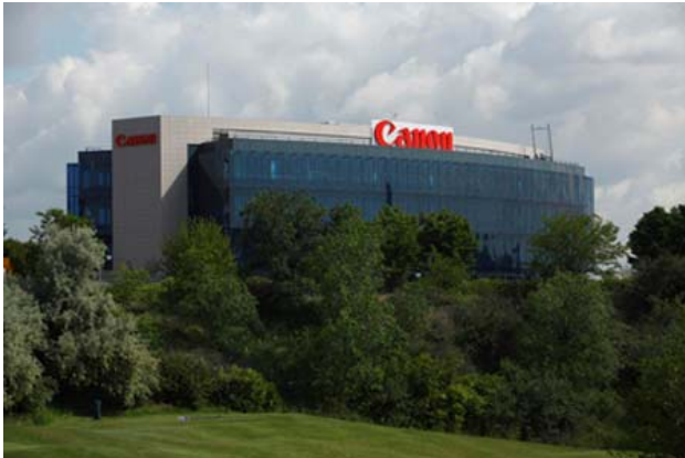
Figura 3: La nuova sede di Canon in Spagna riporta un risparmio energetico del 60% sull'illuminazione e del 40% sul condizionamento grazie all'utilizzo di KNX.
