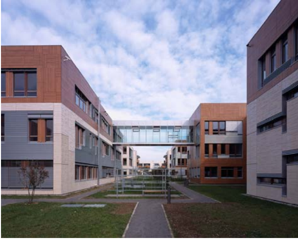
Figura 1: L'ottimizzazione del controllo luce con KNX nella sede di Infineon ha prodotto un risultato più che convincente: un risparmio energetico di oltre 100,000 € in un anno.
