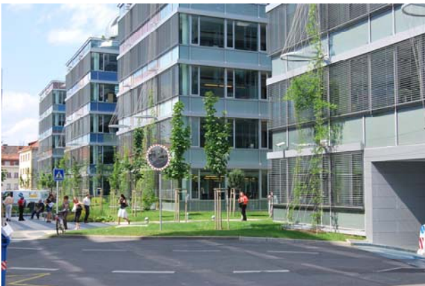
Foto 2: Het hoofdkwartier van het grootste verzekeringskantoor in Tsjechië zorgt voor een verbeterde energiebalans van 60% dankzij genetwerkte automatisering van alle gebouwfuncties via KNX.
