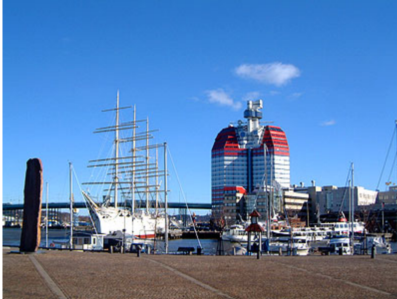
Den gamla fyrmastade barken Viking har installerat ett EIB system för styrning av belysning i restaurangen.
