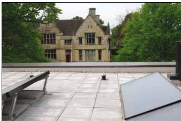
Figur 4. Hållbara resurser: solpaneler för varmvatten försörjningen.
