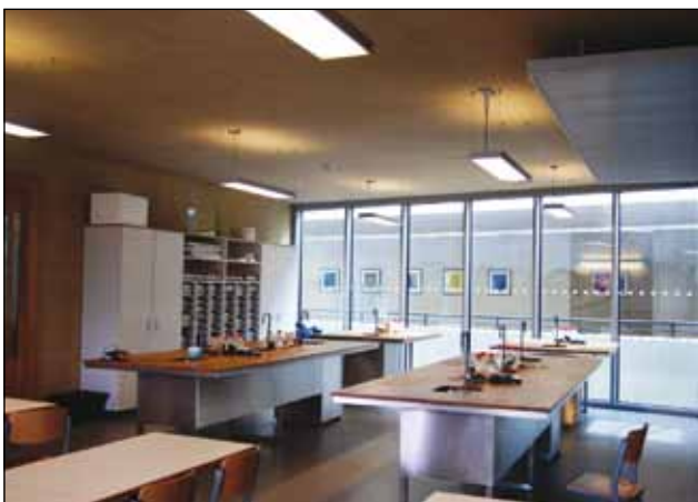
Figur 2. Energieffektivitet 1: konstant ljus-reglering med KNX i laboratorier. Källa: Andromeda
