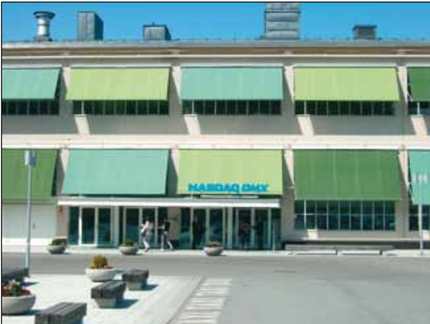
Figur 1. Markiser fungerer som solskjerming og inngår i fasadens design. Kilde: Energoretea
