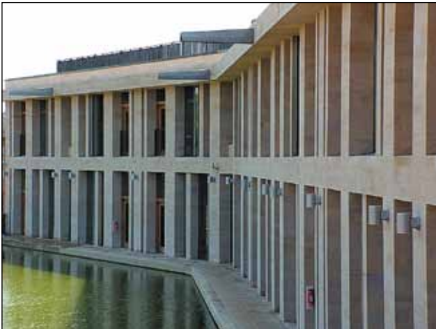
Figura 1. Centro SciTec de Oundle School, el cual reúne ciencia, arte y tecnología, y ha sido construido con la ayuda de tecnologías sostenibles orientadas al futuro tales como KNX. Fuente: Andromeda
