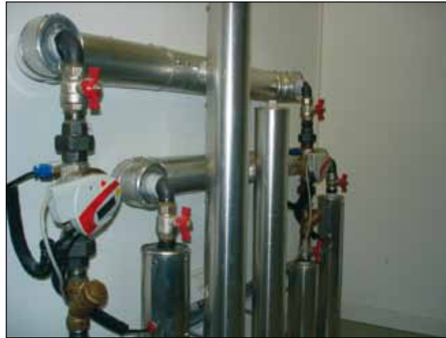
Figura 1. Contador de calefacción con interface M-Bus y pasarela M-bus-KNX
