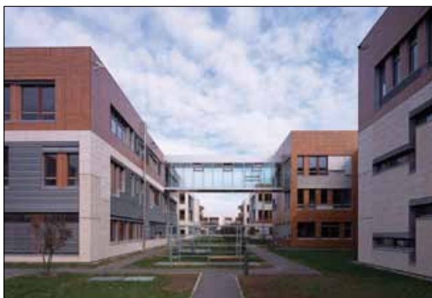
In den Beleuchtungsanlagen zwischen den Gebäudekomplexen ließ sich mit KNX ein deutliches Energie-Einsparpotential erschließen. Foto: Infineon/Heinemann
