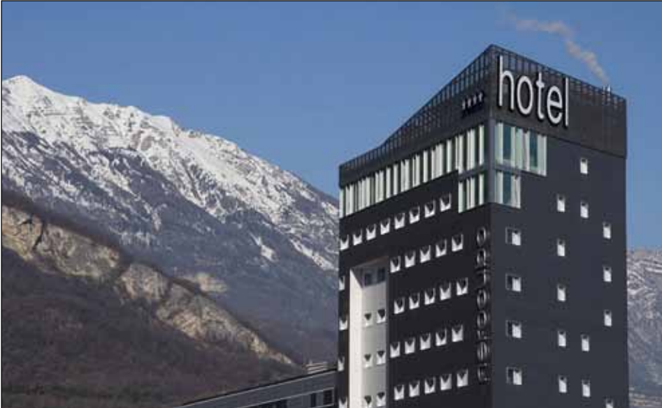
KNX-Funktionen sorgen hier für effiziente Energienutzung
