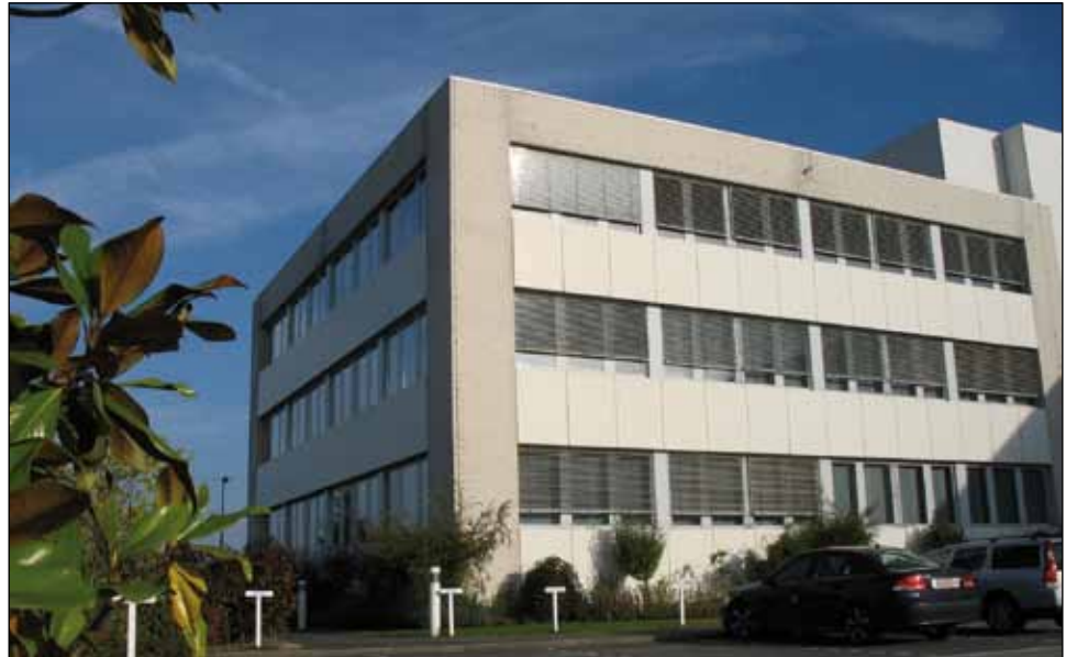
Ein sensorgesteuerter Sonnenschutz reduziert die Kühllast
