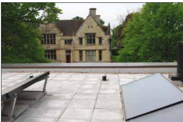
Rys 4. Zasoby odnawialne: panele słoneczne obsługujące zaopatrzenie w gorącą wodę. Źródło: Andromeda
