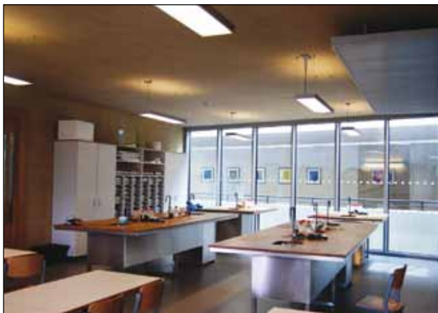
Rys. 2. Wydajność Energii 1: stała regulacja światła przez KNX w laboratoriach. Źródło: Andromeda.
