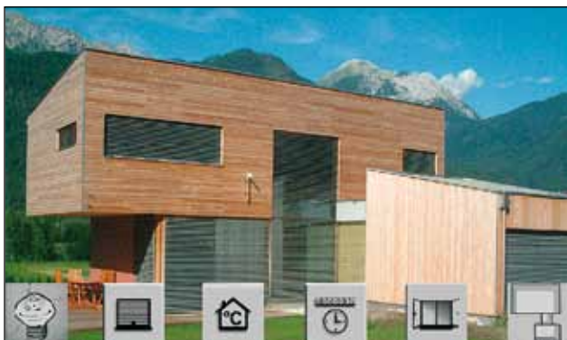
Rys. 1. Niskoenergetyczny dom jednorodzinny.
