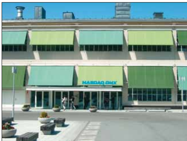
Fig. 1. Le tende esterne sono contemporaneamente elementi per l'ombreggiamento e per il design dell'edificio. Fonte: Energoretea
