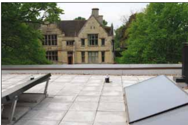
Fig. 4. Risorse sostenibili: collettori solari per l'acqua calda sanitaria.
