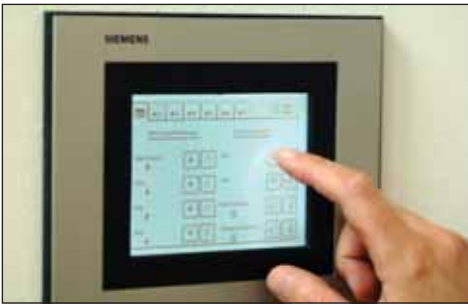
Bild 3. Die Bedienung der Gebäudefunktionen erfolgt über das Touch-Panel UP 588, das auf KNX RF basiert. Figure 3. The operation of the building functions is performed through the touch panel UP 588 which is based on KNX RF.
