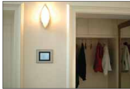
Bild 3. Die Bedienung der Gebäudefunktionen erfolgt über das Touch-Panel UP 588, das auf KNX RF basiert. Figure 3. The operation of the building functions is performed through the touch panel UP 588 which is based on KNX RF.
