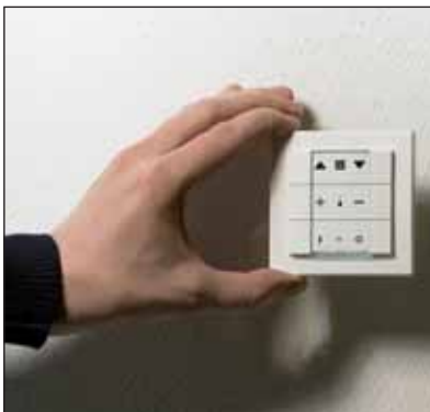
Bild 2. Jederzeit nachrüstbar Figure 2. Retrofitting at any time
