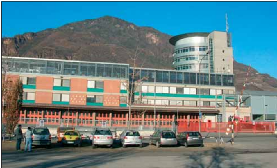
La caserma, con la Torre Uffici sullo sfondo / The fire brigade station, with the office tower block in the background
