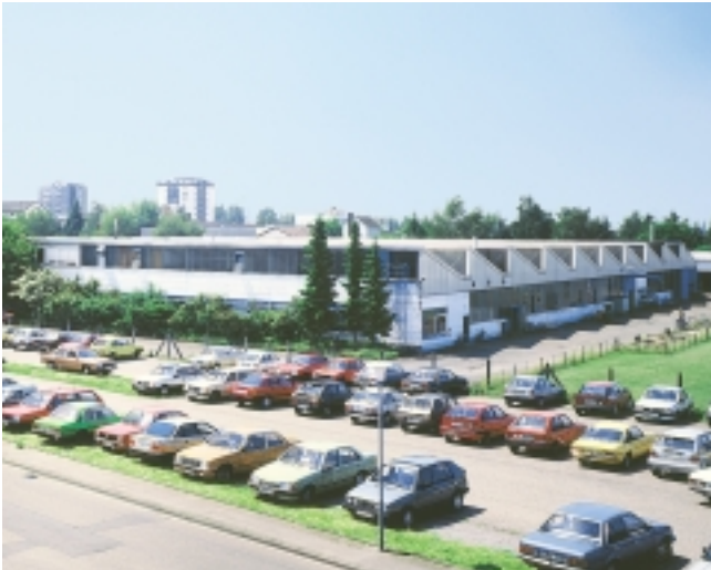
Standort Eppelheim/ Betriebsmittelbau Seestraße 71 69214 Eppelheim Telefon (0 62 21) 701-510
