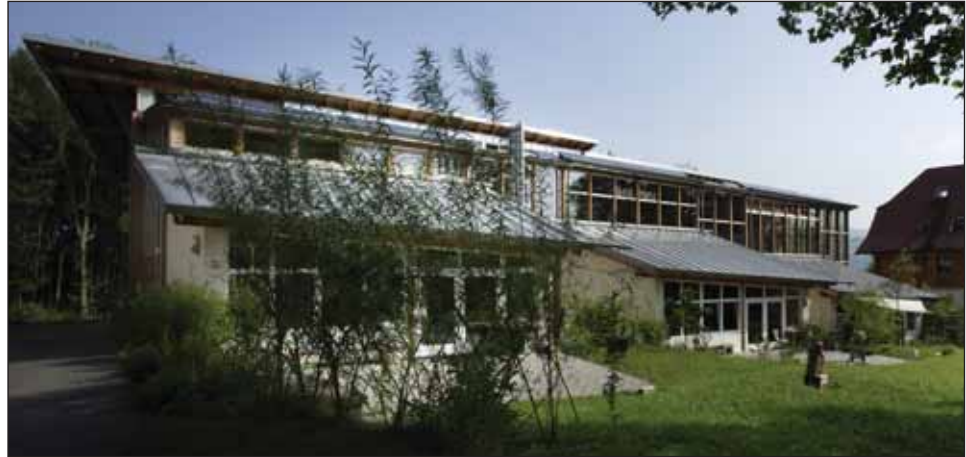
Bild 1. Die Rückansicht des Schulgebäudes bietet einen Eindruck von den riesigen Fensterflächen, die lüftungstechnisch gemanagt werden müssen. Dazu versorgt eine Wetterzentrale auf dem Dach die zentrale Steuerung mit Daten.
