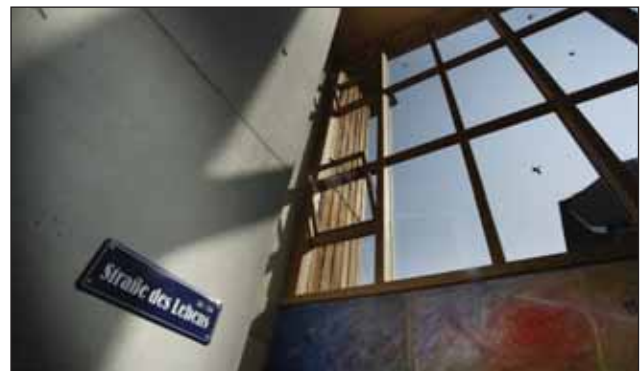
Bild 3. Nur durch eine wirksame automatische Steuerung der Fenster kann sommers wie winters ein angenehmes Raumklima gewährleistet werden.
