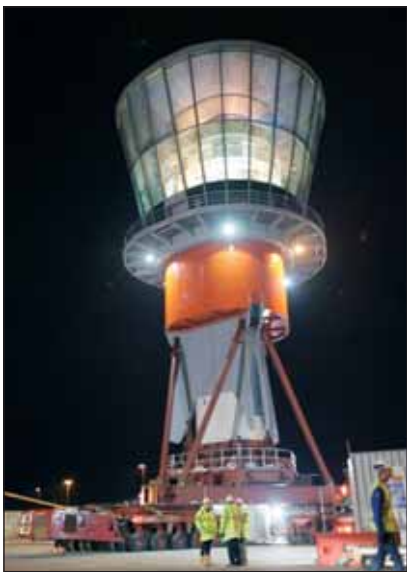
Bild 3. Teile des Controltowers auf dem Weg zu seinem Standplatz
