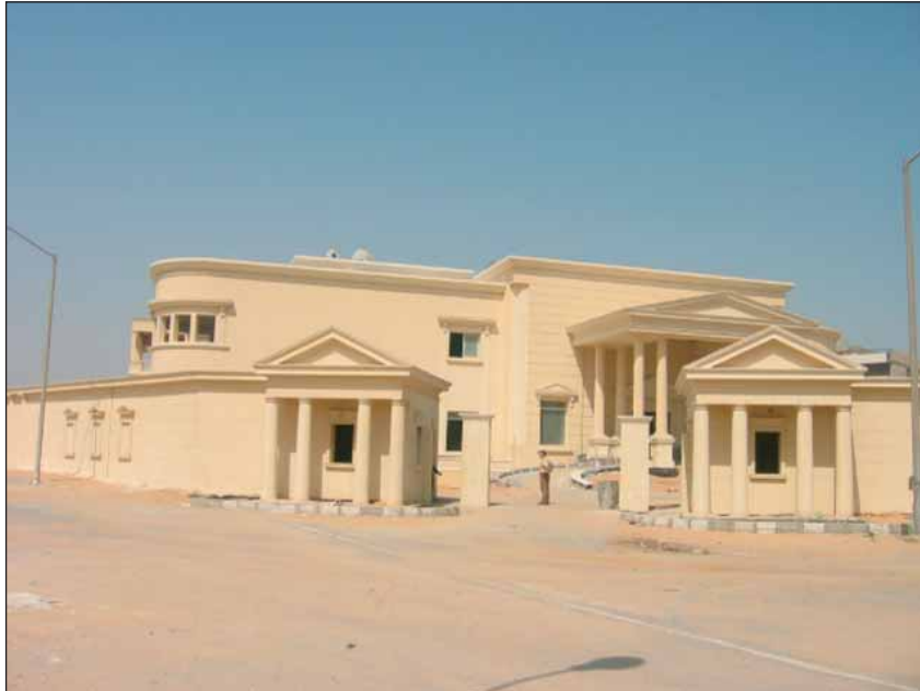
Bild 1. Blick auf die herrschaftliche Villa mit KNX-Steuerung in der Nähe von Kairo
